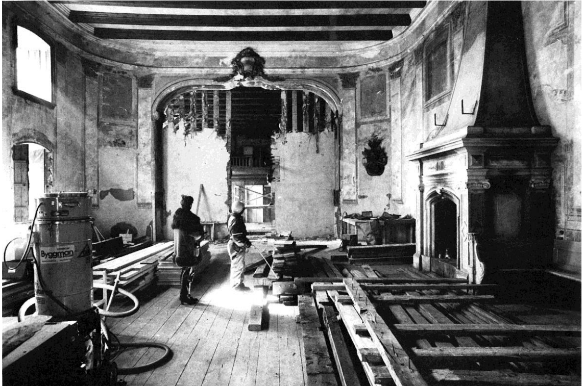
Den igensatta scenöppningen började rivas 1977 under Kjerstin Dellerts överinseende
