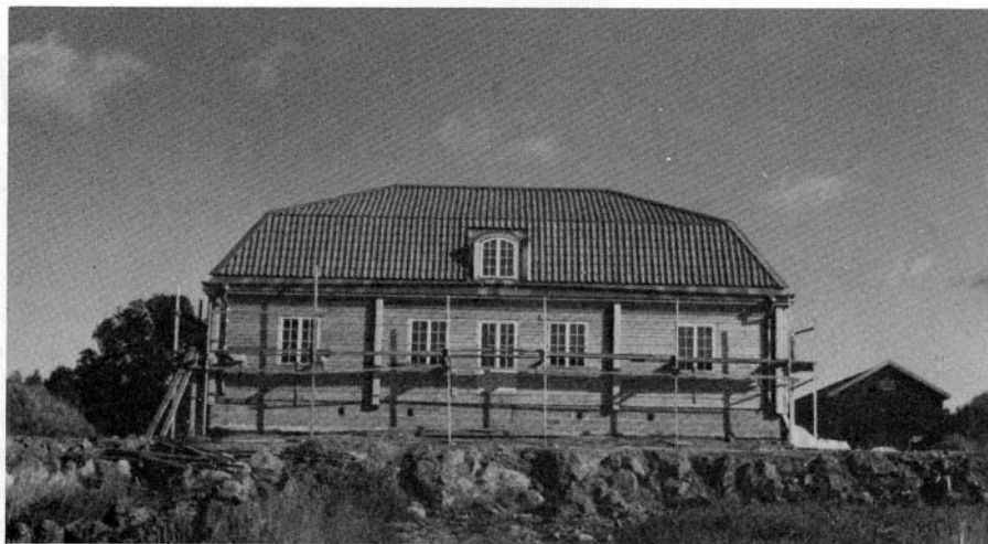
Huset under uppbyggnad. Skorstenarna är ännu inte uppmurade. Huset står på en terrass uppbyggd av fyllnadsmassor från ett vägbygge.
